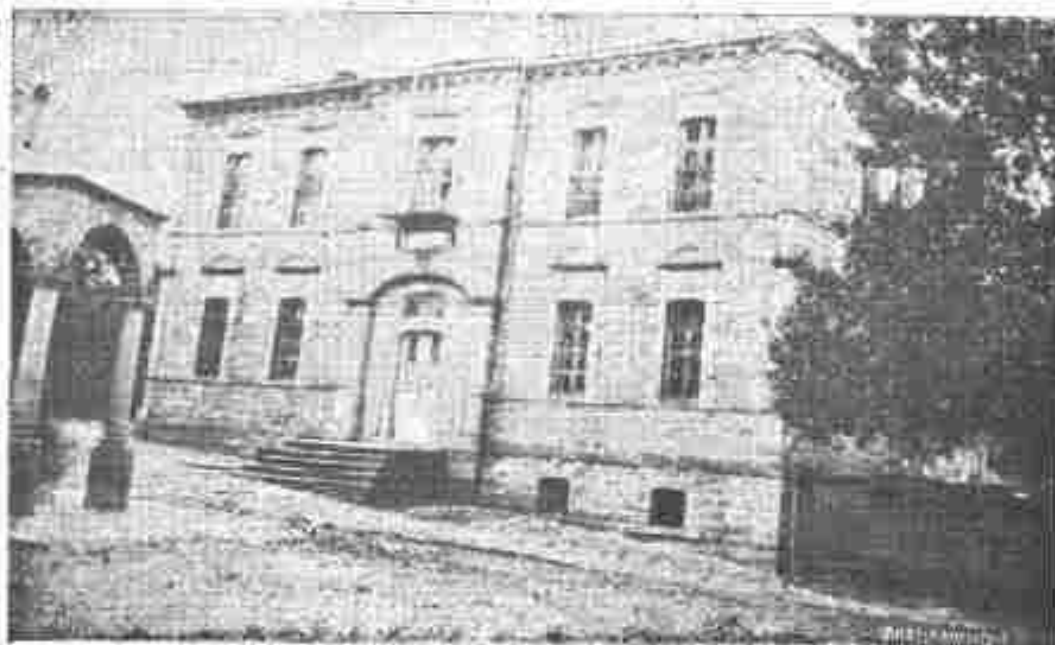
Τὸ καλλιμάχηρον Σχολεῖον εἰς τὸ δυτικὸν τῆς εὐρυχώρου πλα- τείας Κρηνίσι ἐστραμμένον πρὸς ἀνατολὰς καὶ ἔναντι ἀκριβῶς τῆς ἐκκλησίας. Ἀνηγέρθη ἀποκλειστικῶς δαπάνῃ τῶν Κρηνηνι- τῶν (1904). Ἐν αὐτῷ ὑπάρχει μεγάλη αἴθουσα τελετῶν, αἴθουσα συνεδριάσεων καὶ γραφεῖον Κοινότητος αἴθουσα βιβλιοθήκης καὶ δύο αἴθουσαι παρεδύσεων.
